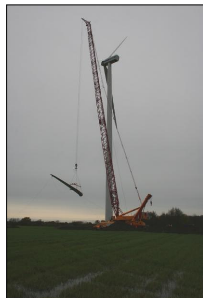
Figur 15. Montage av vindkraftverk.
