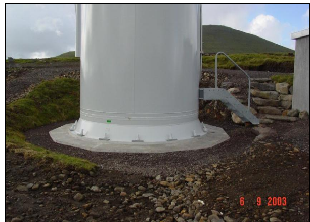
Figur 13. Foto på bergförankrat fundament
